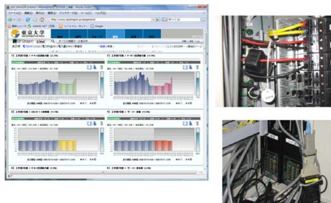
図 4. 電力使用量リアルタイムモニタシステム
