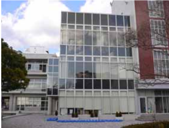
写真3．小学校管理棟（2Fが校長室）
