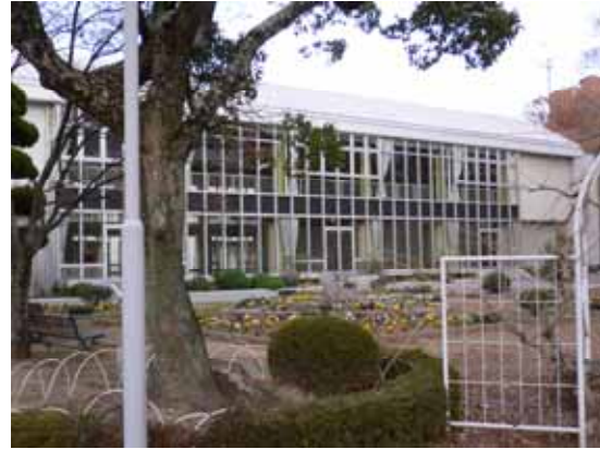
写真4．事件後改修された体育館
